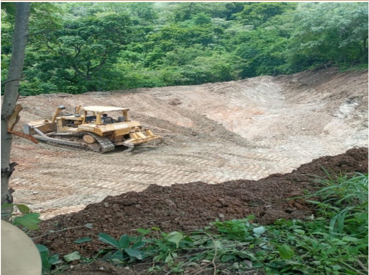
Construcción de Olla Captación de agua en El Montón
