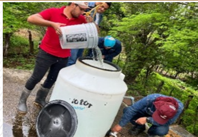
Aplicación de Hipoclorito de Sodio
