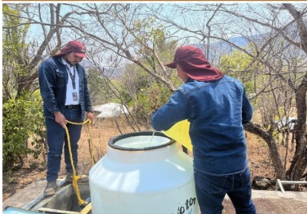
Cloración a sistemas de agua potable
