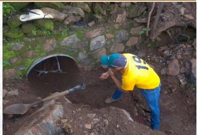
Desazolve de alcantarillas Región Centro
