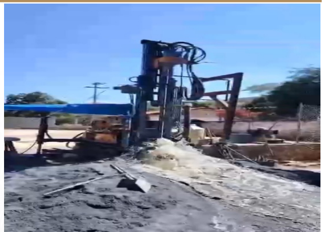
Perforación de Pozo en El Salitrillo
