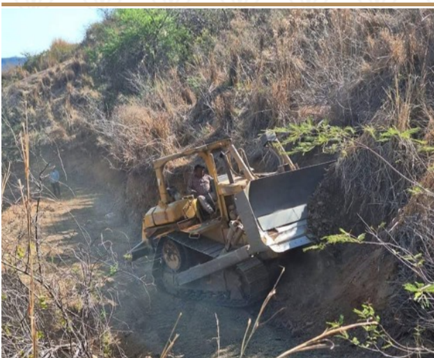
Construcción de Olla de Captación de agua en El Limón
